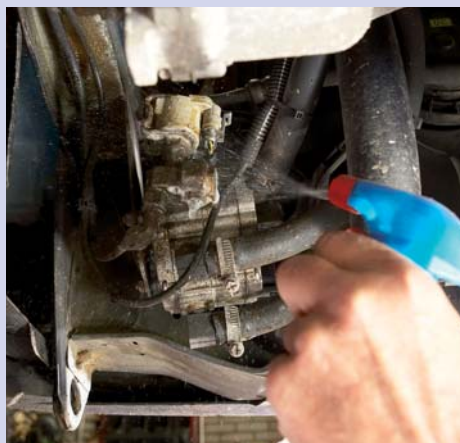
Controleer iedere beurt de conditie van de slangen en verbindingen en loop ze na op lekdichtheid.
