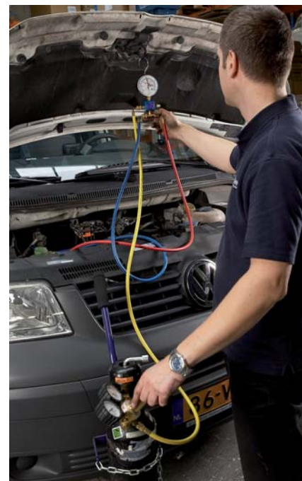
Spoelen met stikstof is een alternatief, maar het is de minst effectieve methode. Het afpersen wordt ook toegepast om te controleren of de installatie niet lekt.
