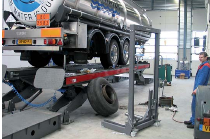
Onder een halfschaarbrug staat niets de bandenwagen in de weg.
