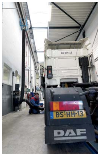
In de APK-straat moet de uitlaatgasafzuiging met het voertuig mee. Van daar de rail.
