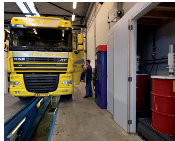
Vet over grote afstand verpompen geeft veel drukverlies. Daarom staat het niet in de milieuruimte, maar zo dicht mogelijk bij de aftappunten. Het wordt verpompt via naadloze hogedrukleidingen.
