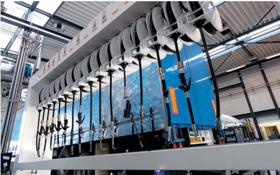
Valt het op dat de kabinetten vrijstaand zijn aan de bovenkant? De leidingen mogen niet bovenlangs, anders kan de kraan er niet overheen. Daarom gaan de leidingen buiten de kraanbaan langs de grond in. Via gecertificeerde PE-buizen bereiken ze de aftappunten.
