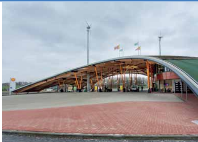
De dôme is in het landschap ingepast en daarom niet voorzien van zonnepanelen, maar van sedumplantjes (op de laagste paar meter na). De vetplantjes binden de CO 2 -uitstoot, verminderen fijnstof en hebben een waterbufferend vermogen.
