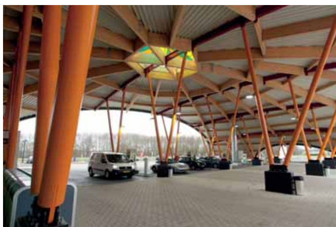
Vreemd idee: tanken onder een dak van sedumplantjes. In het hart van het houten spinnenweb zijn kleurige glazen panelen aangebracht.
