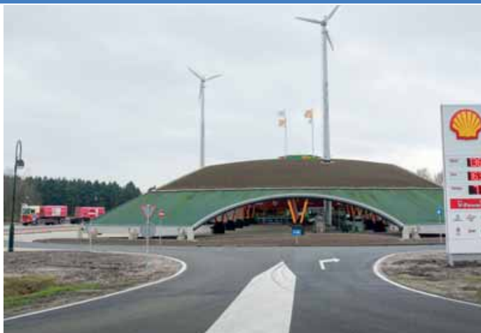
Green Planet ligt aan de oprit van de A28; daar waar de A28 de N375 elkaar kruisen. Het is mogelijk om de dôme heen te rijden. Personen- en bestelauto's tanken onder de dôme; vrachtauto's tanken aan de buitenkant ervan (links).
