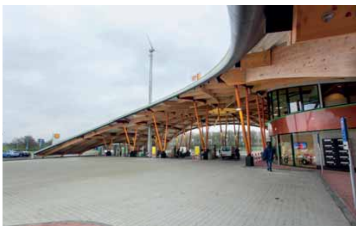
Het dak wordt gedragen door een houten spinnenwebachtige constructie. Hout neemt CO 2 op, maar het blijft bijzonder om het als constructiemateriaal bij een brandstofstation te gebruiken.
