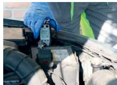
Met een stroomtang controleert Michael Möschler de laadstroom.
